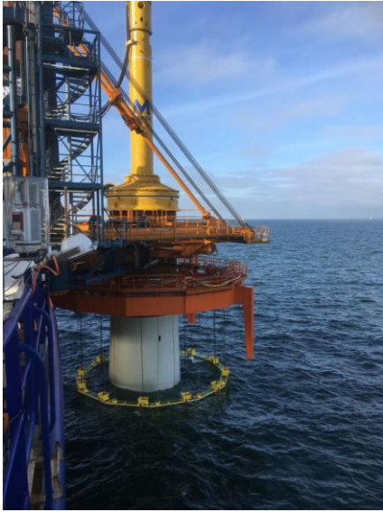
Van Oord'i löökrammimise seadmestik
